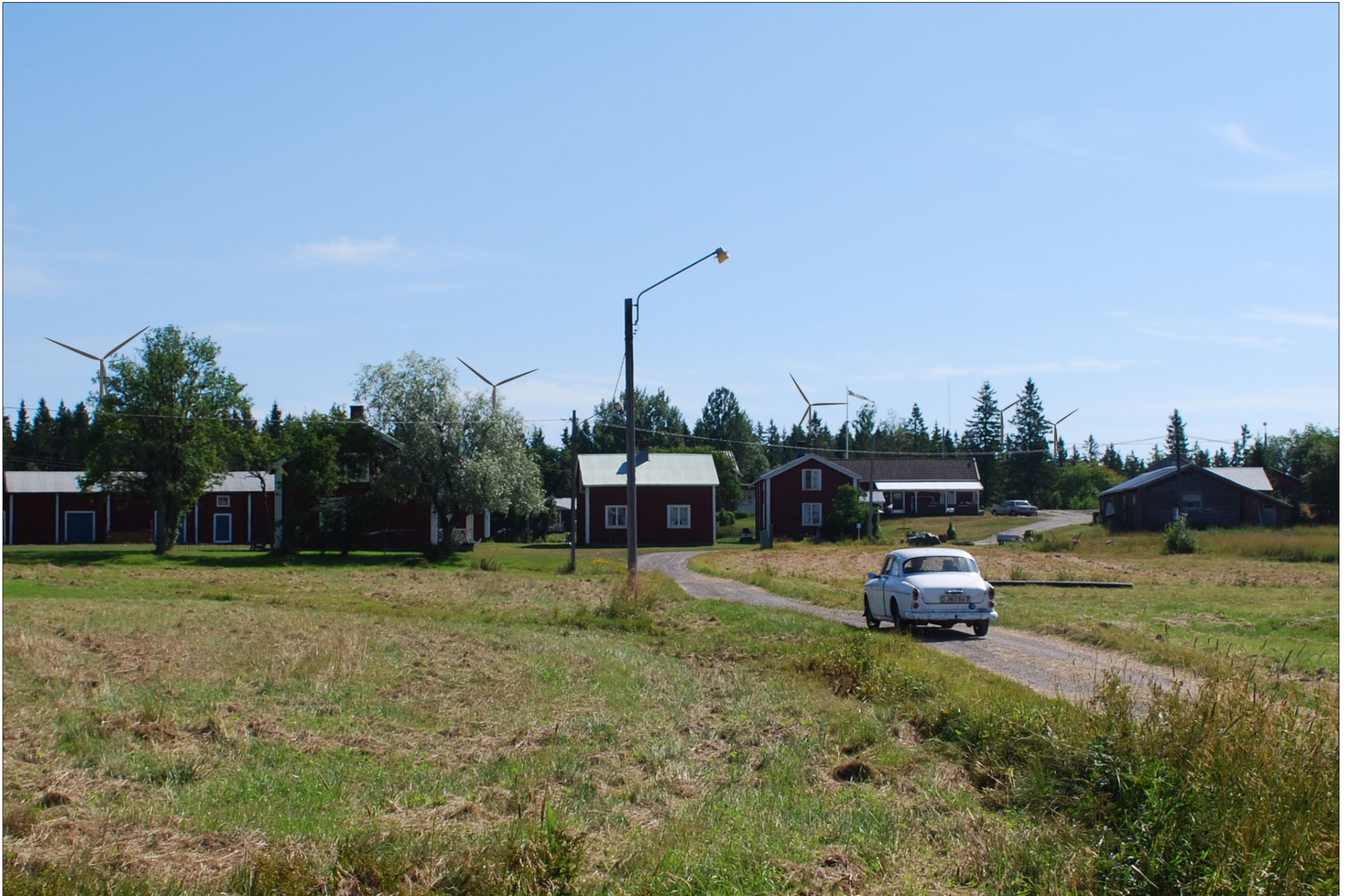
Fotopunkt 13. Vy mot öster från vägen vid Vägverkets gamla personalbostad.
